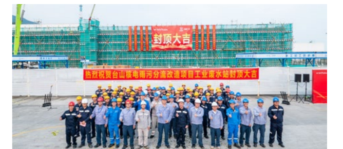
台山核电雨污分流改造项目工业废水站封顶
