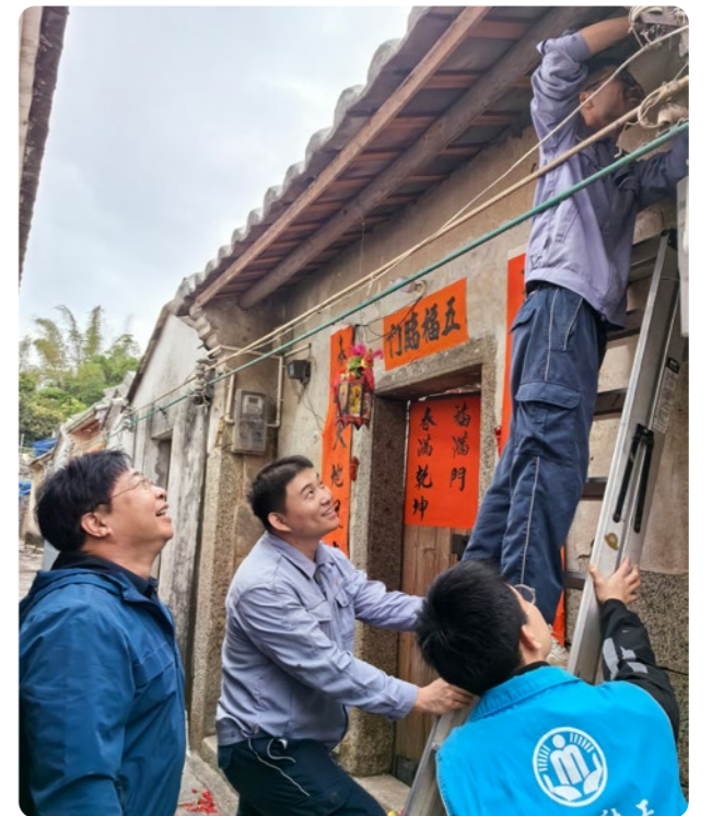
工作人员开展电路隐患排查
